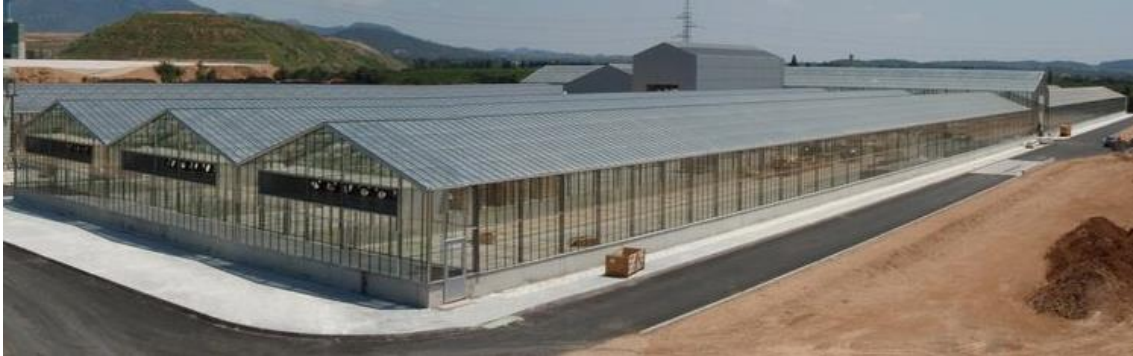
Figura 2 Tipico sistema di serre per l'essiccamento dei fanghi privo di trattamento arie
