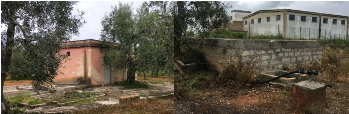
Figura 21 Manufatto esistente su are di nuova realizzazione
