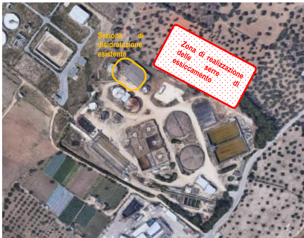
Figura 2 Vista satellitare dell'impianto
